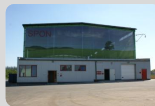
Stacja Przeładunku Odpadów Niebezpiecznych
