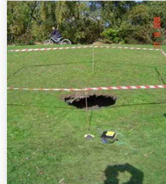
Zapadlisko w rejonie szybu V KWK Pniówek
