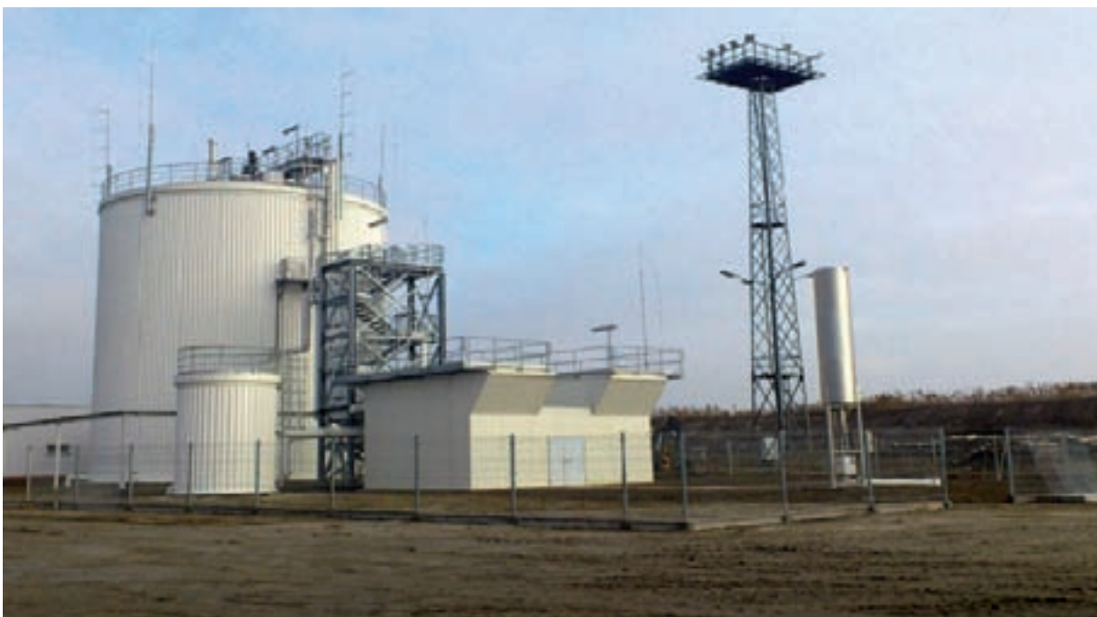
Fot. 2. Stopień beztlenowy oczyszczalni w Werbkowicach.
