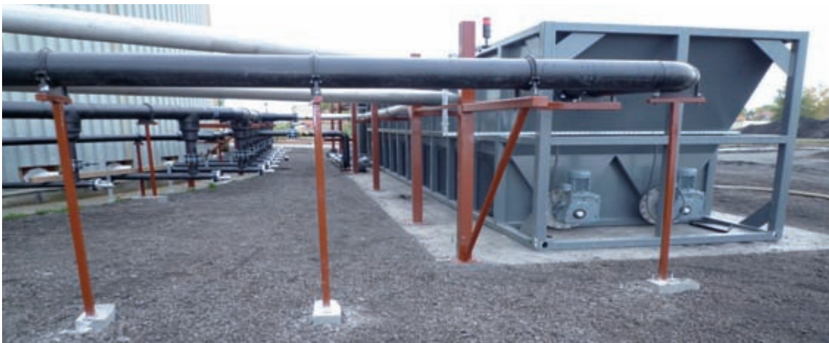
Fot. 1. Modernizacja stopnia beztlenowego w Malborku.
