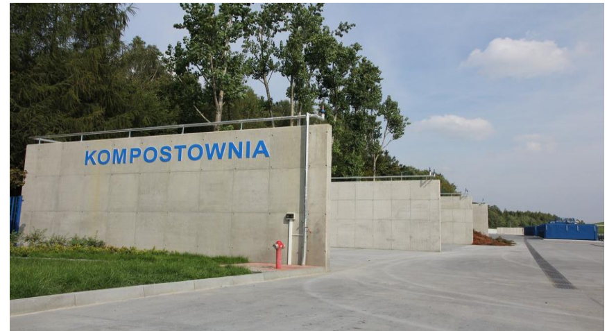
Kontenerowa kompostownia odpadów zielonych Barycz
