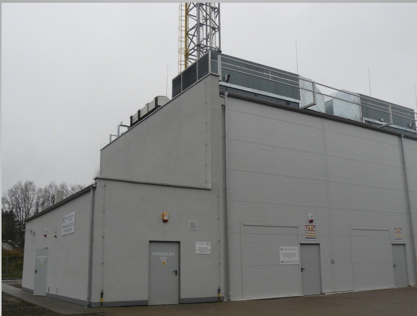
Ciepłownia „Śląsk” 2014 r.
